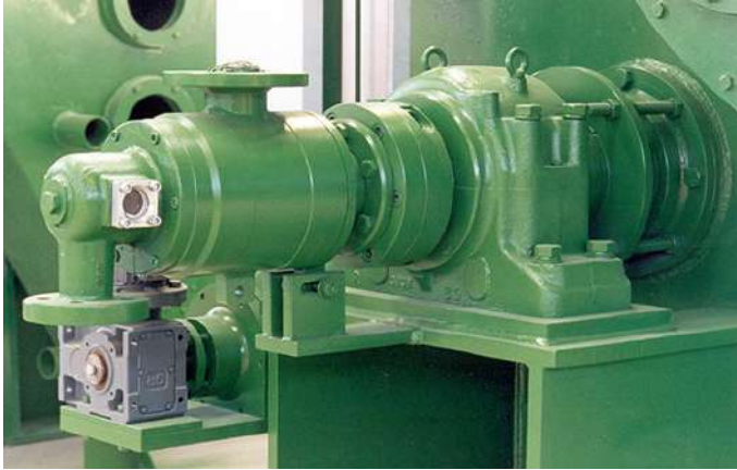
DETALHE DA JUNTA DO VAPOR DO BUCIM
